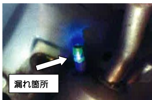
図 1：空調の冷却オイル漏れ
